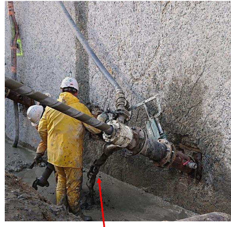
Coulis de ciment
