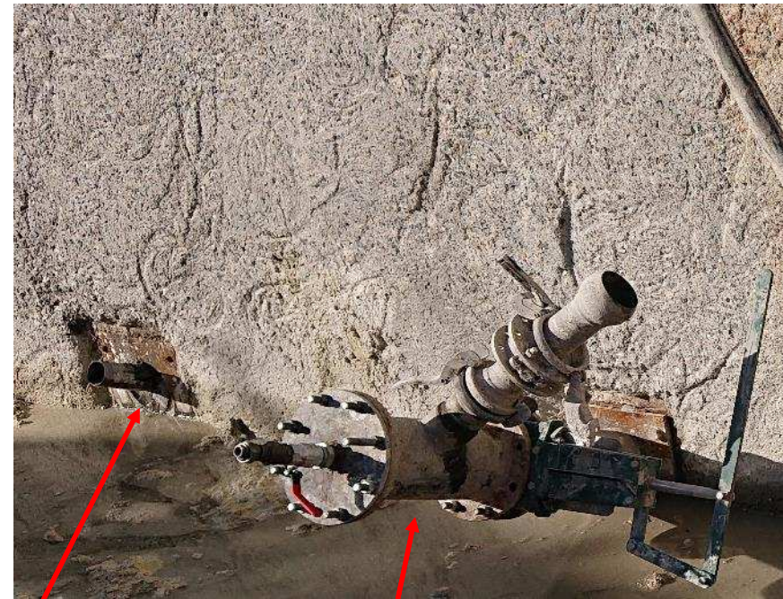
Partie du SAS en place pendant la prise du scellement gravitaire
